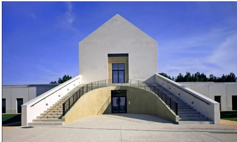
Le crématorium de Martigues
